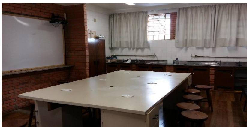
Figura 4: Laboratórios com estrutura precária.
