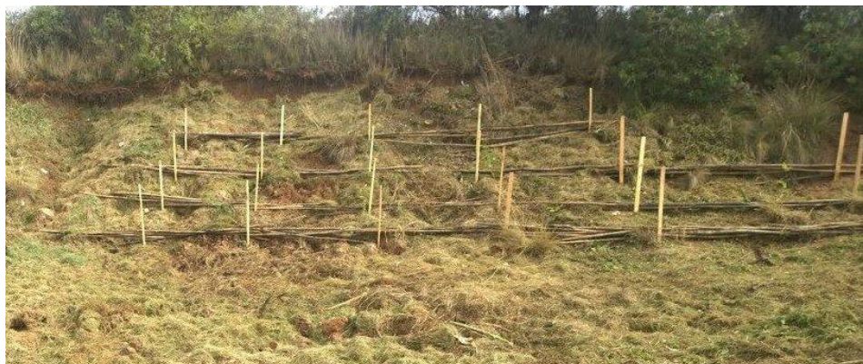
Figura 1. Obra de bioengenharia do tipo paliçada em talude de declividade suave.
