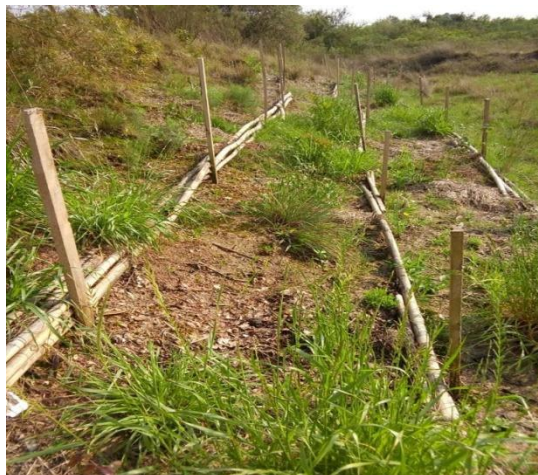
Figura 3. Talude após dois meses de implantação.
