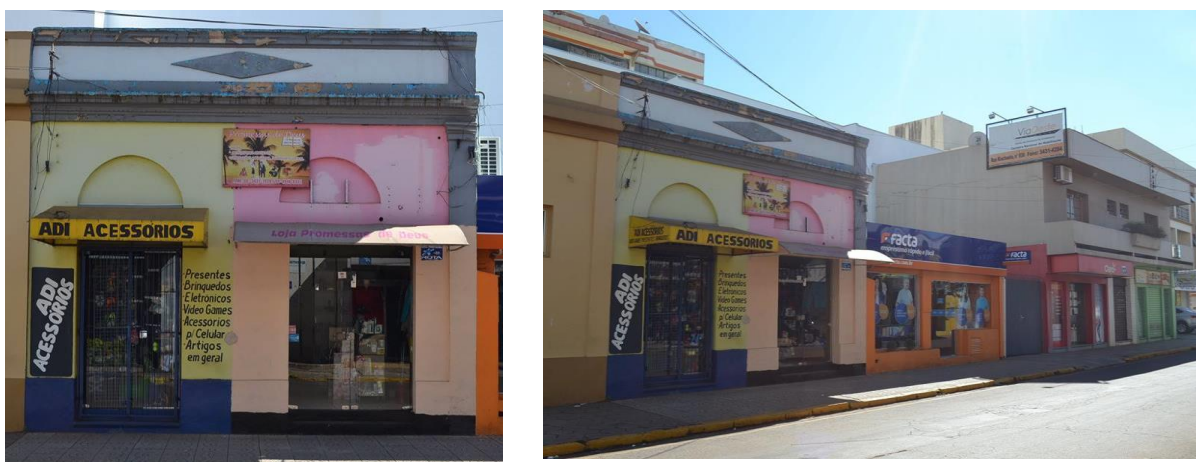
Figura 1 frontal da fachada e diagonal da fachada.
